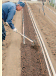
↑地中冷暖房用管を植床へ埋設する。
